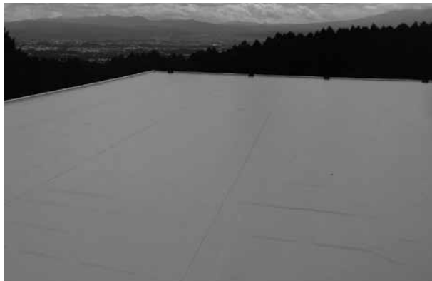
サーナルーフ完成後
