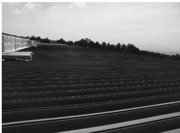
サーナルーフ断熱防水折半屋根施工前
