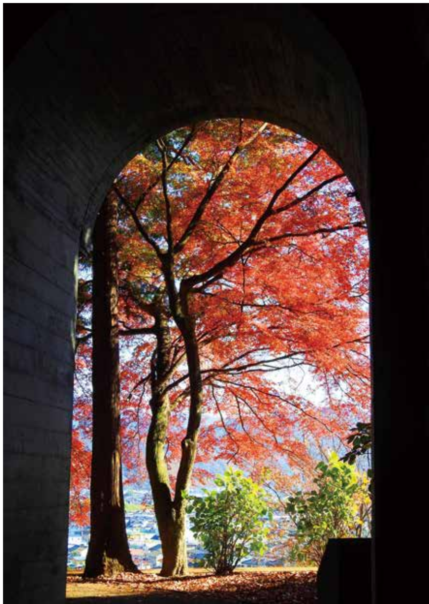
千曲市 桑原 龍洞院架道橋 【登録有形文化財】 橋長7.4m・幅員21m
