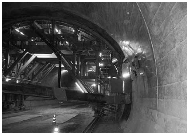
トンネル壁面探査(非破壊)
