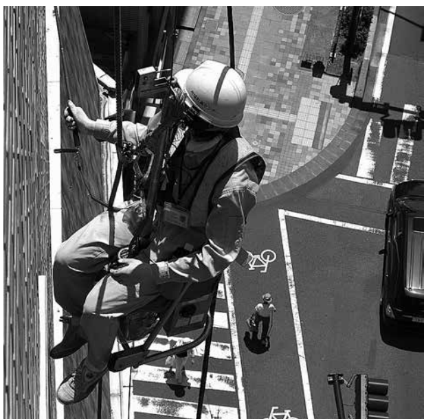
壁面打診検査(建築)
