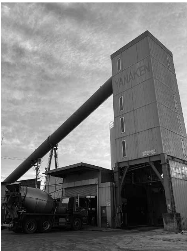
本社のセメントプラント
