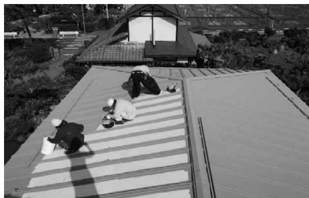
一般住宅の屋根の現場
