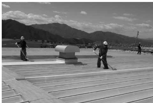
工場屋根の現場
