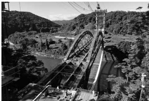
橋梁塗装の現場
